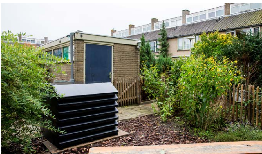
Buitenunit met een geluiddempende omkasting
